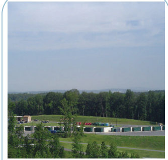
Landfill Convenience Center
