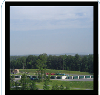
Landfill Convenience Center
